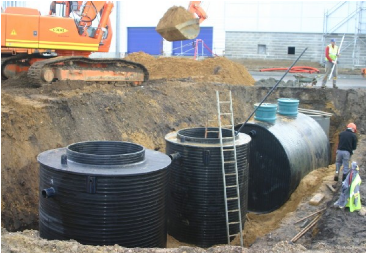
Principe de mise en place Installation industrielle (Dépôt Leclerc - 72470 CHAMPAGNE) - Travaux effectués par Ent. COLAS -
